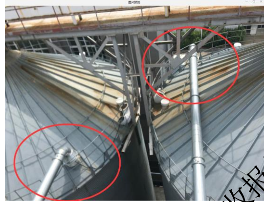
整改后筒仓呼吸口管道密封收集
