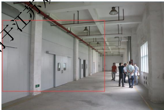
生产车间隔声墙
