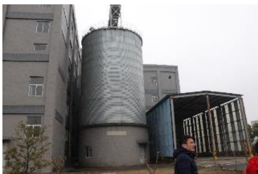
整改前原料筒仓（未密封收集颗粒物）
