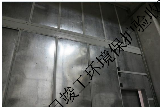
厂房地侧墙壁上安装多孔吸声板
