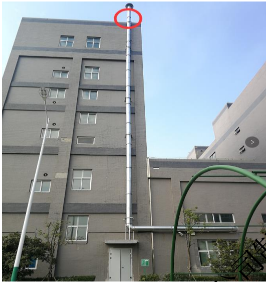
整改后颗粒物排气筒采样口
