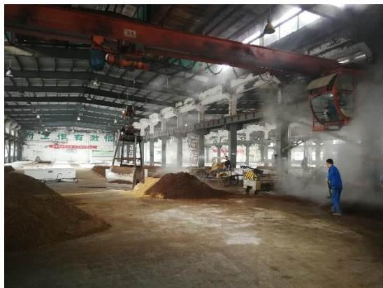
整改前 218 酿酒车间内部
