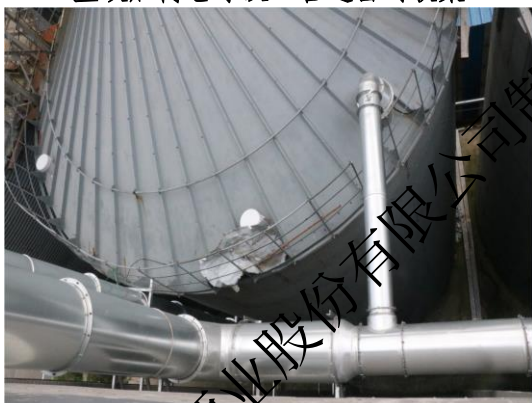
整改后筒仓呼吸口管道密封收集
