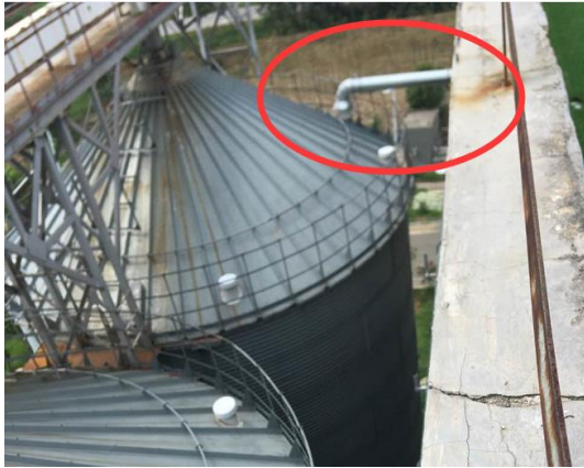
整改后筒仓呼吸口管道密封收集
