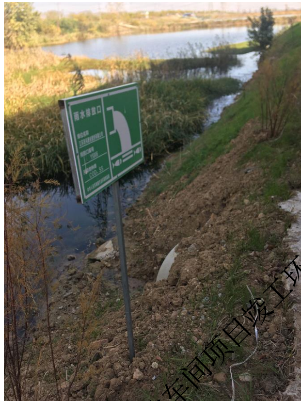
制曲车间设施的雨水排放口标识牌
