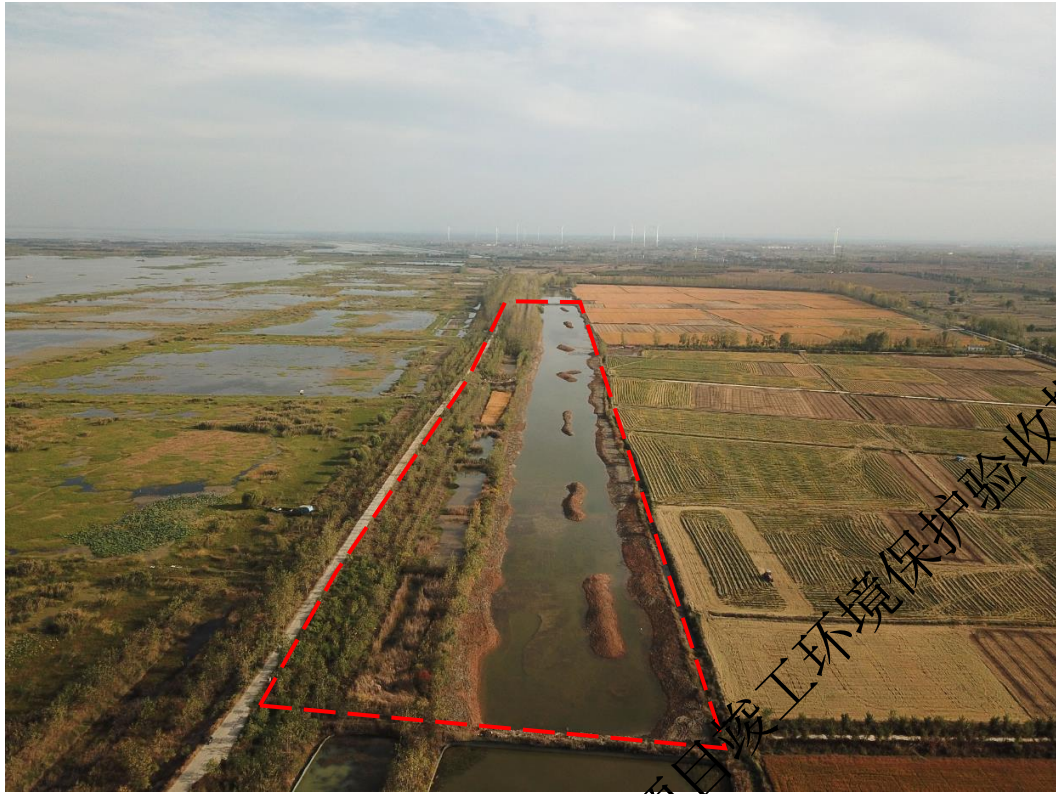
1 号生态修复区实施后航拍图（2020 年 11 月 3 日）
