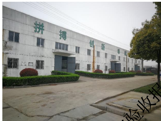
整改前 218 酿酒车间外部
