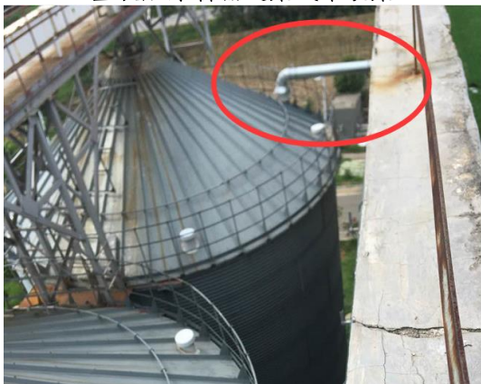
整改后筒仓呼吸口管道密封收集
