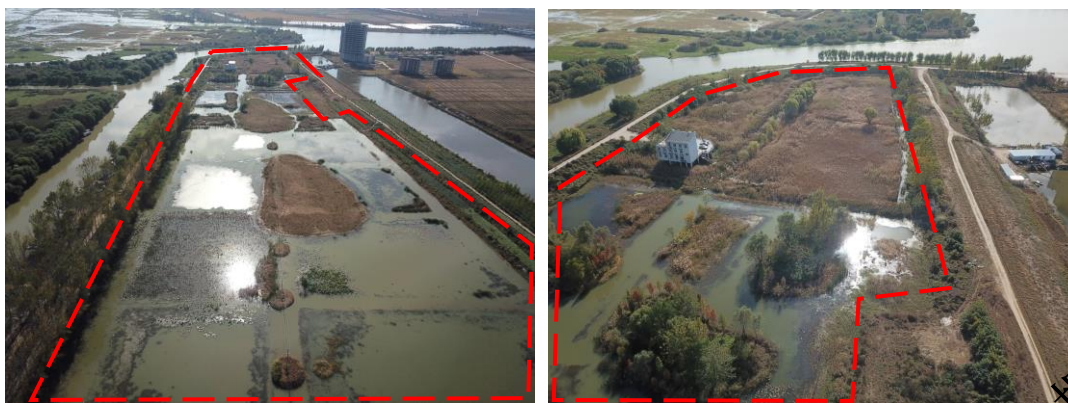
2号生态修复区实施后航拍图（2020年11月3日）
